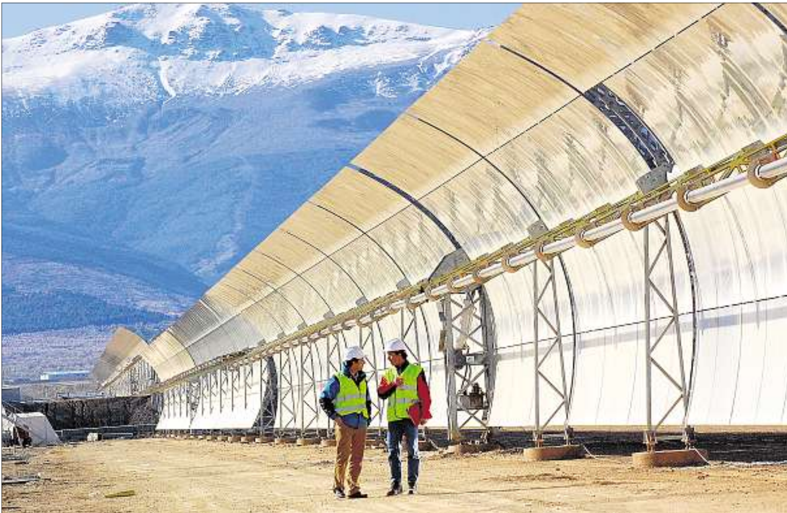
Am Fuße der spanischen Sierra Nevada hat Schott Kernkomponenten für das erste europäische Solarthermie-Kraftwerk geliefert. (Fotos [2]: OTZ/Lutz Prager)
